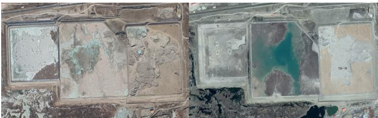
Зураг 8-4 ДЦС-4-ын үнсэн сангийн ашиглалтын байдал (2018 оны хавар, өвөл)
