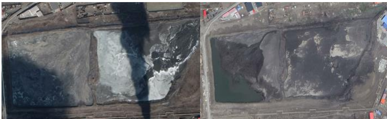
Зураг 8-2 ДЦС-2-ын үнсэн сангийн ашиглалтын байдал (2018 оны хавар, өвөл)
