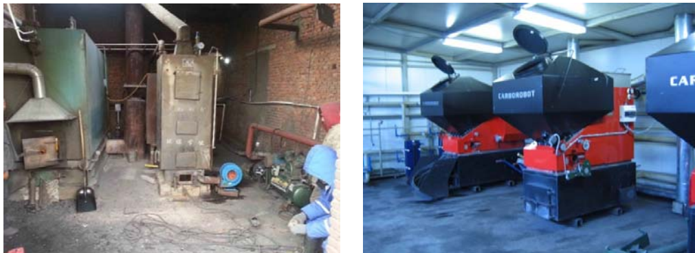
Зураг 3. Гэр хороололд байрлах сургууль, цэцэрлэг, буудал гэх мэт томоохон объектуудыг халааж буй уурын болон усан халаалтын 100кВт-4МВт хүртлэх хүчин чадалтай зуух
