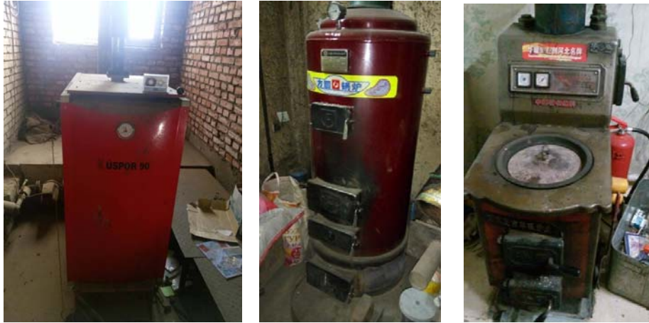
Зураг 2. 125 м2-аас дээш талбайг халааж буй нам даралтын усан халаалтын зуух
